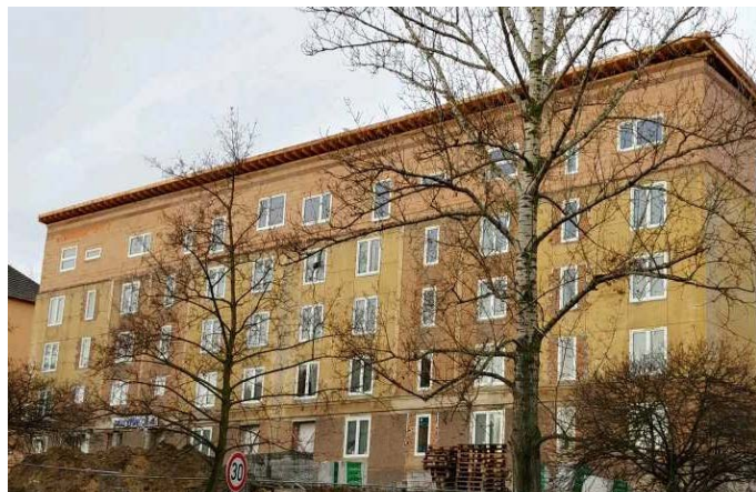
Rekonstrukce objektu je v plném proudu
